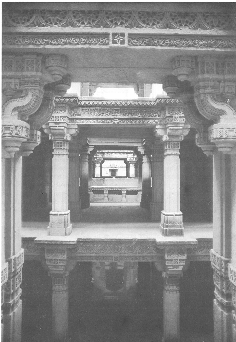
Nel baoli di Adalaj la struttura trilitica di contenimento delle pareti laterali contiene la scala di accesso all'acqua
