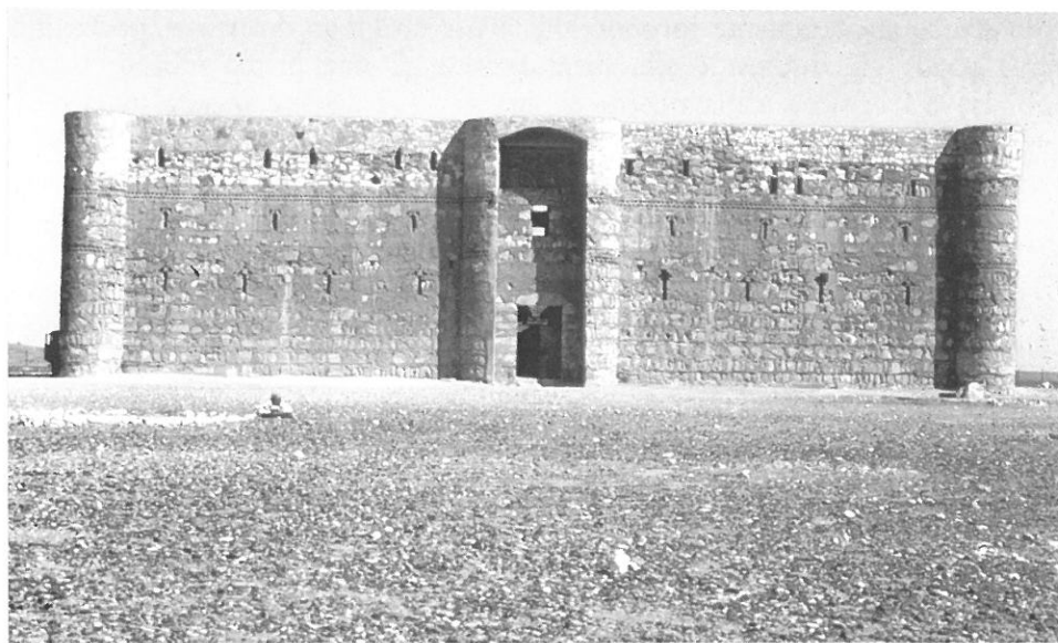
Il castello di Qaranah in Giordania. Fronte principale (Aga Khan Foundation).
