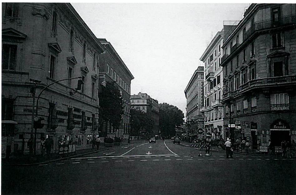
L'imbocco di via Arenula dal Lungotevere, sulla sinistra il villino Scafi progettato da Filippo Galassi sull'area del preesistente isolato 24, di fronte il palazzo Macchi dell'architetto Giovanni Riggi.
