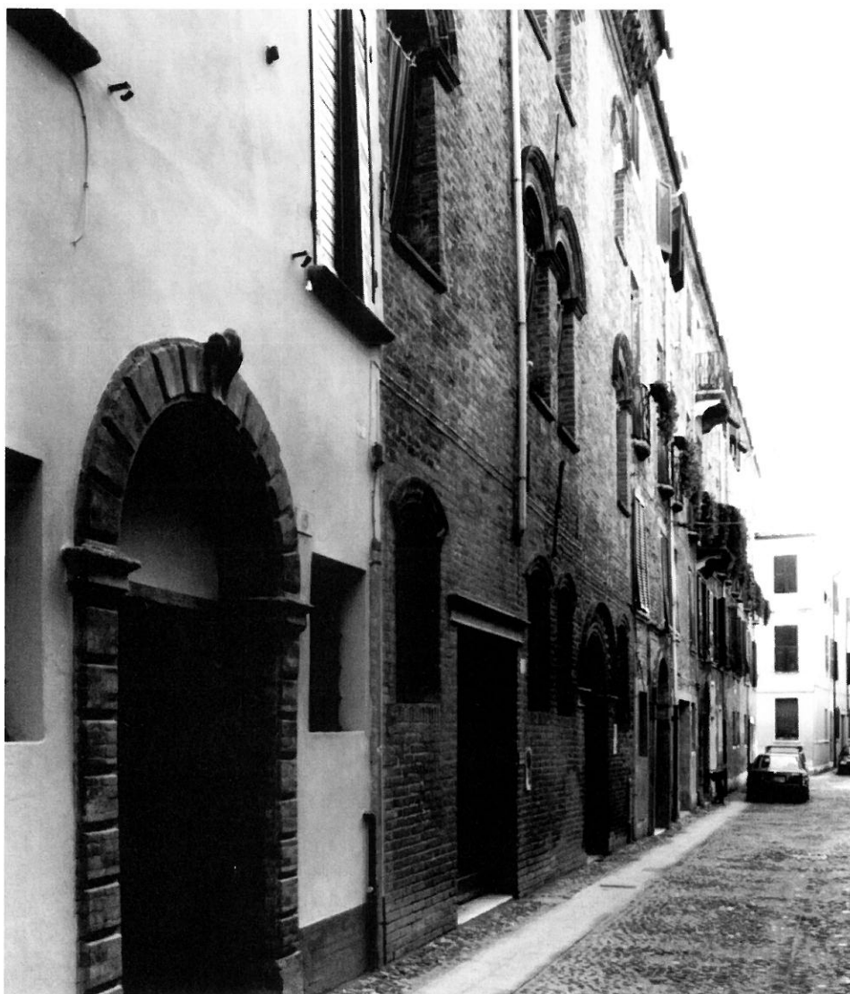
Via Vittoria. Al centro della foto casa con ricca ornamentazione in cotto, fine sec. XV, attribuita all'ambito di Biagio Rossetti (1447ca.-1516). Foto M. Baraldi
