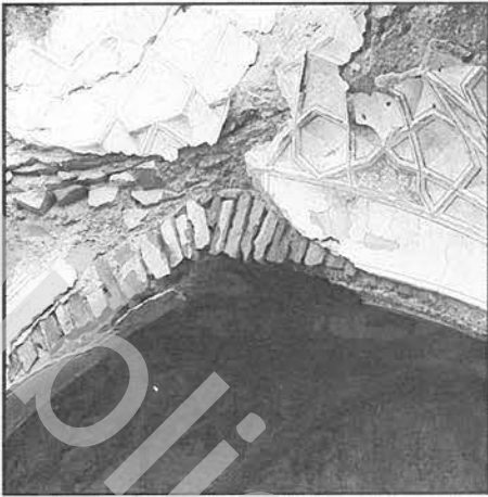
Fig. 216. Dettaglio in chiave di un iwan realizzato sommariamente in muratura di mattoni.
